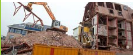
sloop en recycling
